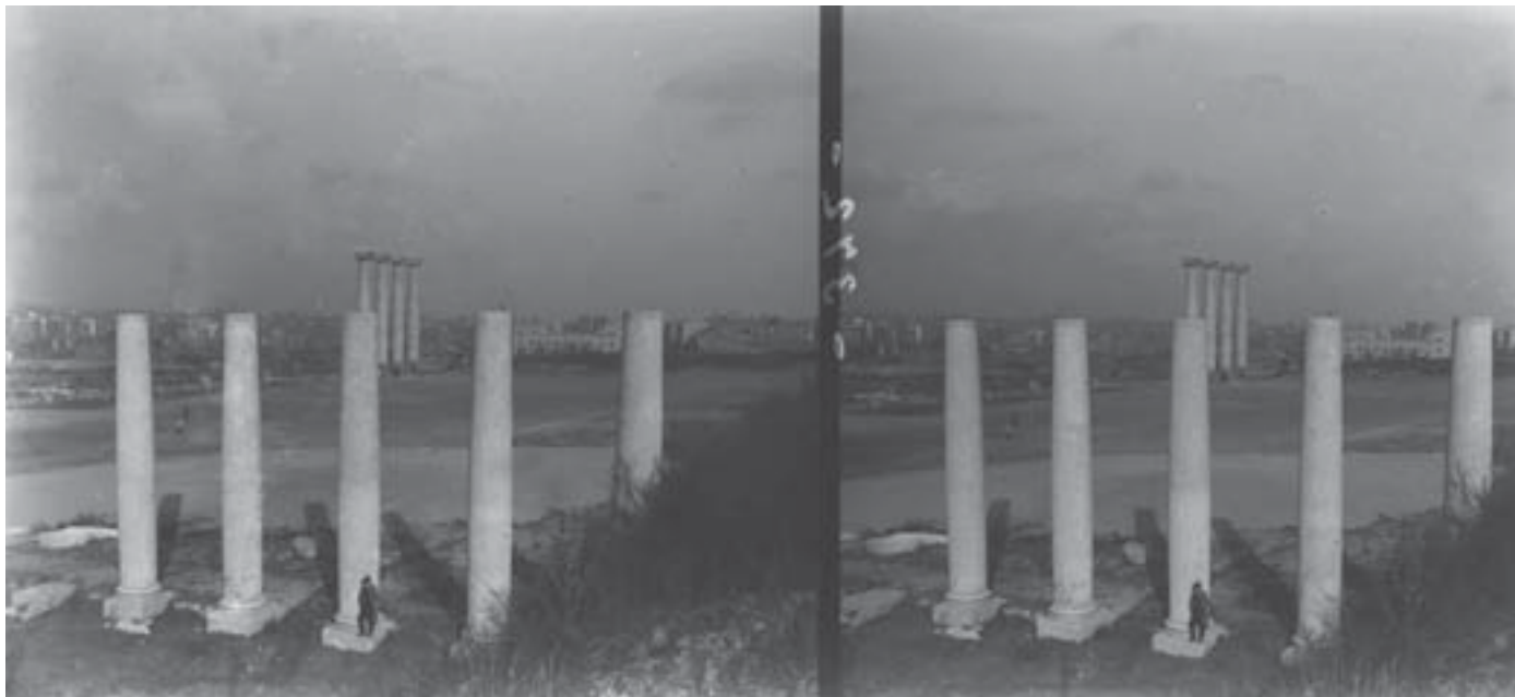
Vista general de les actuals avingudes Maria Cristina i Rius i Tauler a Montjuïc. En primer terme, destaquen les probables obres de construcció del Palau Alfons XIII i darrere, en segon terme, les quatre columnes també ideades per l'arquitecte i president de la Mancomunitat de Catalunya, Josep Puig i Cadafalch. La imatge correspon a una placa de vidre estereoscòpica 6x13 i fou presa l'any 1921.
